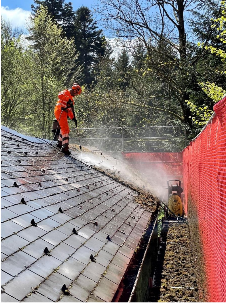
Bild 2: Zivilschützer befreit das Dach von Moos
