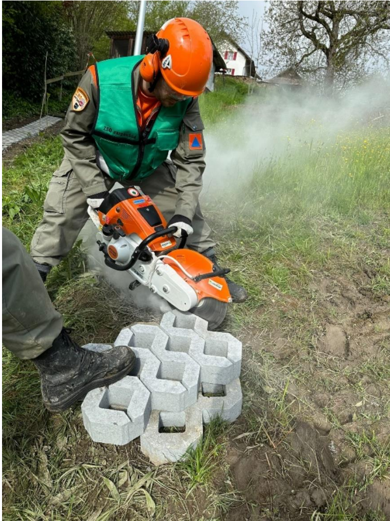
Bild 1: Zivilschützer beim Zuschneiden von Rasengittersteinen
