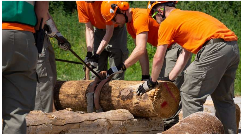
Pioniere beim Aufbau eines Schmutzwasserbeckens
