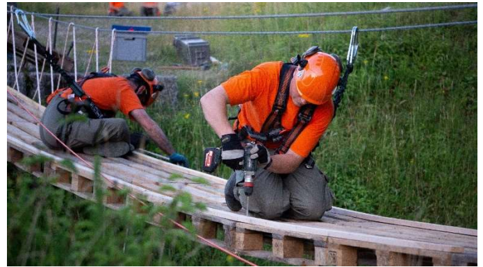
Aufbau einer provisorischen Fussgängerbrücke
