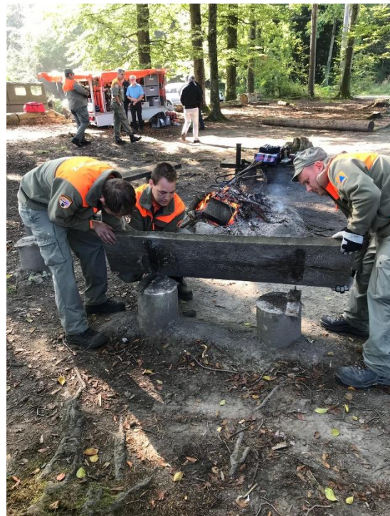
Demontage einer alten Sitzbank bei der Feuerstelle Wannenhof, Unterkulm
